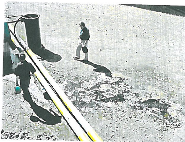
Photo n°5 Débordement du séparateur- décanteur
