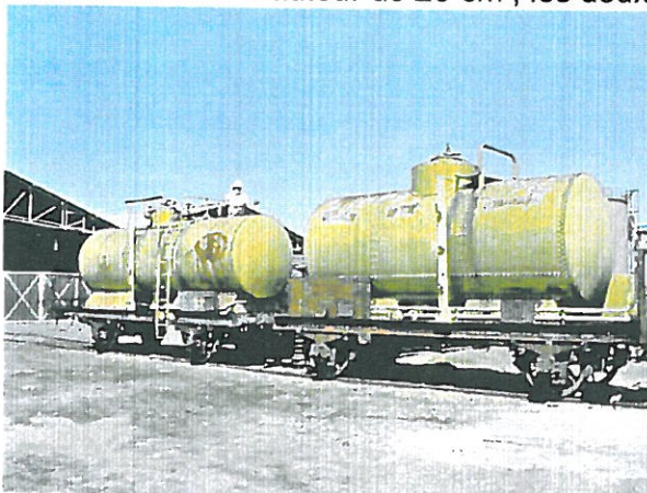
Photo n°15 Stockage huile turbine près de la zone de stockage des déchets
